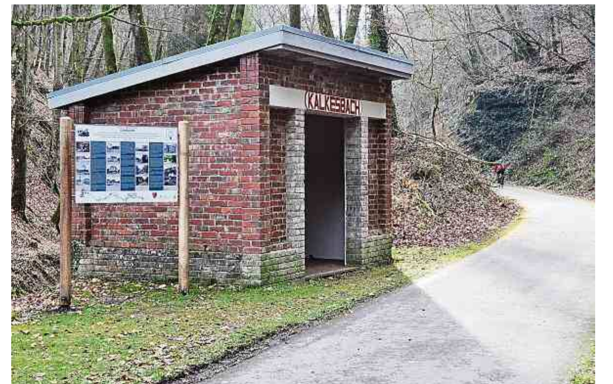
Das restaurierte Haltehäuschen Kalkesbach, früherer Haltepunkt der Eisenbahnlinie „Charly“.
