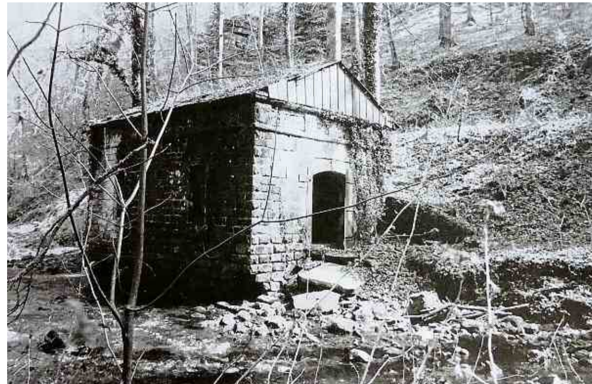
Ein Foto vom Pompelhaischen von 2003. Es wird bald wohl abgerissen. (Fotos: Armand Reuland und Fred Schaaf)
